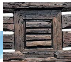
Dýmný otvor mezi okny ve štítu.
